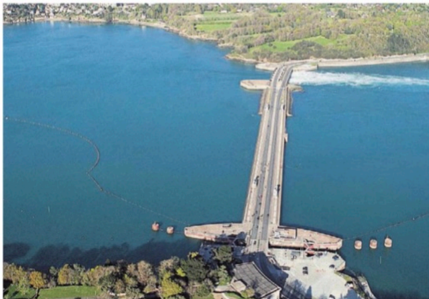
L'usine marémotrice et le barrage mobile de la Rance produisent chaque année l'électricité correspondant à la consommation annuelle de 225 000 habitants.
